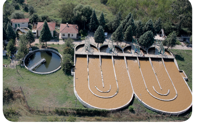
İnegöl Yenice Atık Su Arıtma Tesisi
