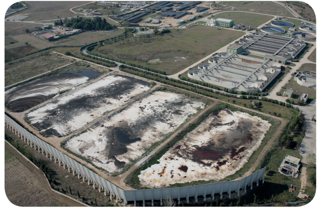
Batı (Özlüce) Atık Su Arıtma Tesisi
