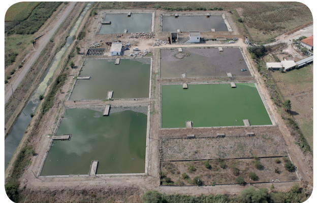
Karacabey Atık Su Arıtma Tesisi
