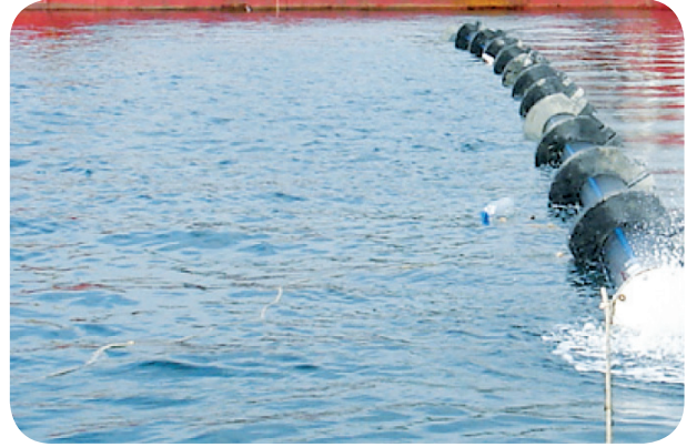
Mudanya Atık Su Ön Arıtma ve Derin Deniz Deşarjı Tesisleri
