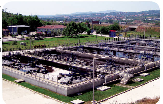
Kent Katı Atık Depolama Alanı Süzüntü Suyu Arıtma Tesisi
