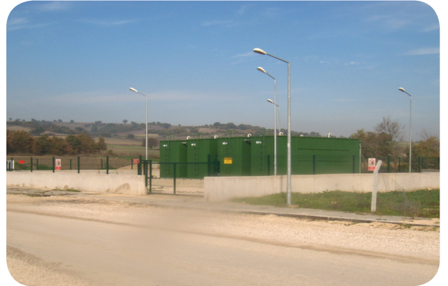
Kayapa Paket Atık Su Arıtma Tesisi
