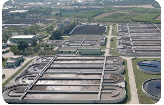
Doğu Atık Su Arıtma Tesisi
