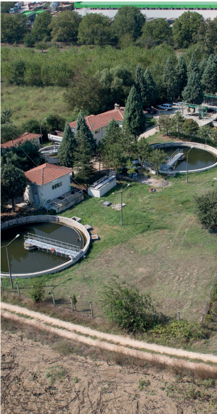
Atık Su Arıtma Tesisi
