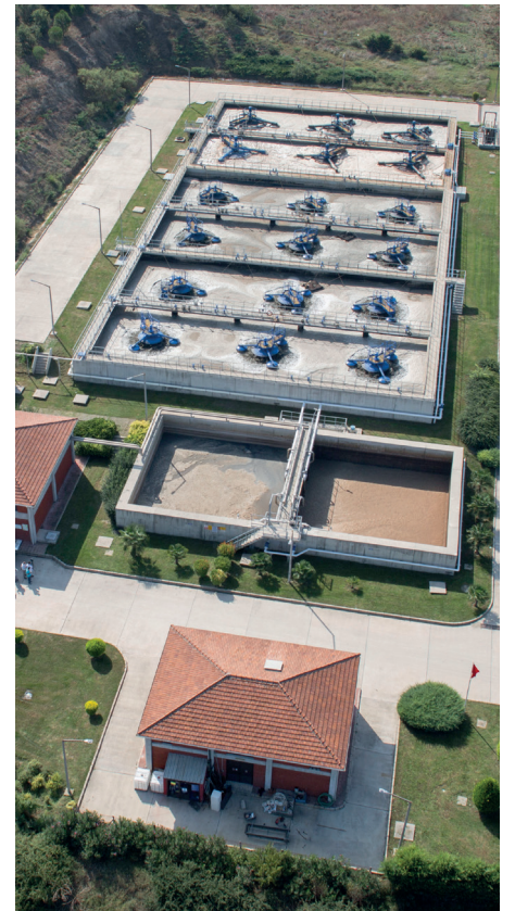
Atık Su Arıtma Tesisi
