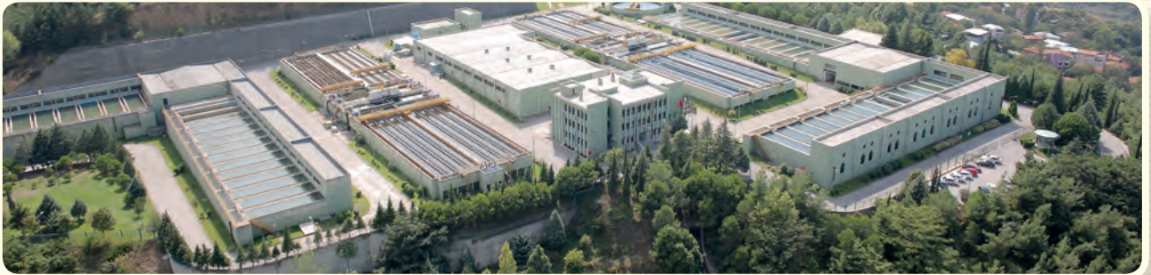
Dobruca Arıtma Tesisi
