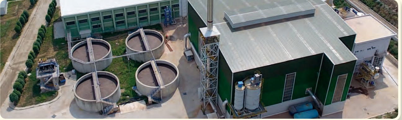
Çamur Yakma Tesis
