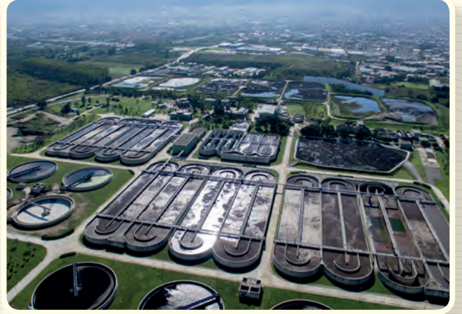
Doğu Atıksu Arıtma Tesisi
