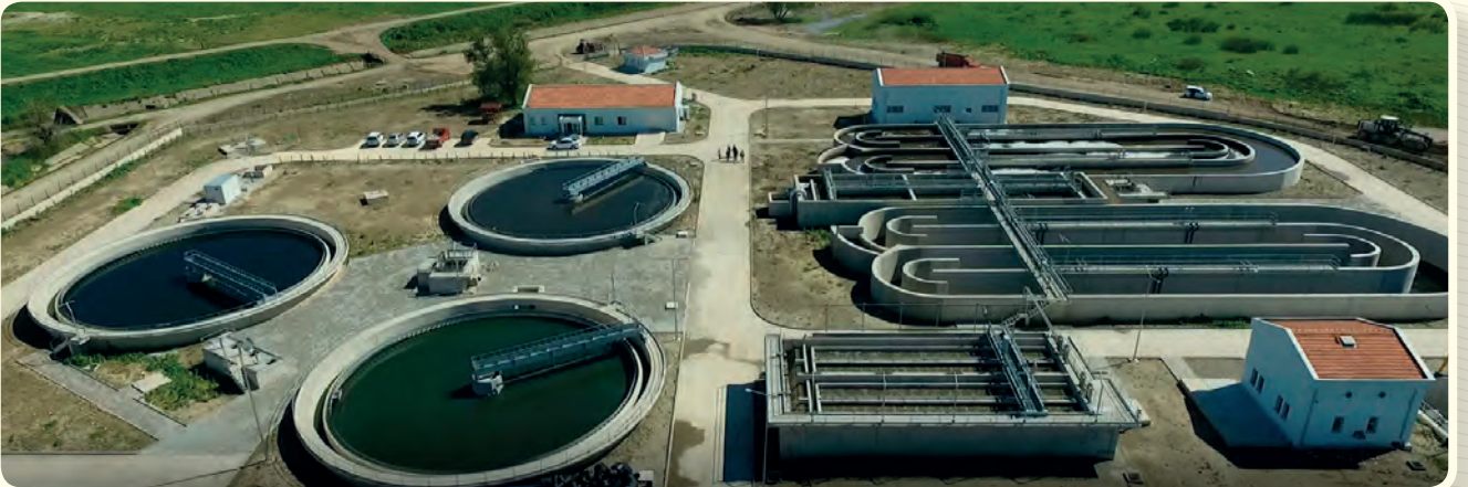
MKP Atıksu Arıtma Tesisi
